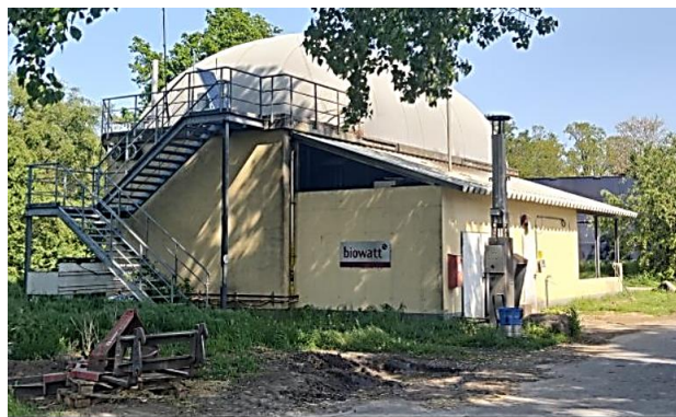
BioCNG-Hoftankstelle im praktischen Betrieb im Rahmen des Res4Live-Projekts.
